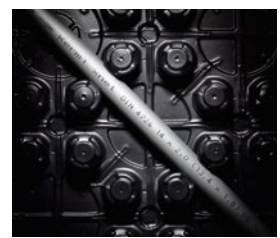
Диагональная укладка без использования вспомогательных средств
