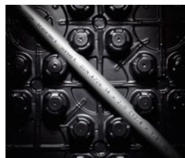
Диагональная укладка без использования вспомогательных средств
